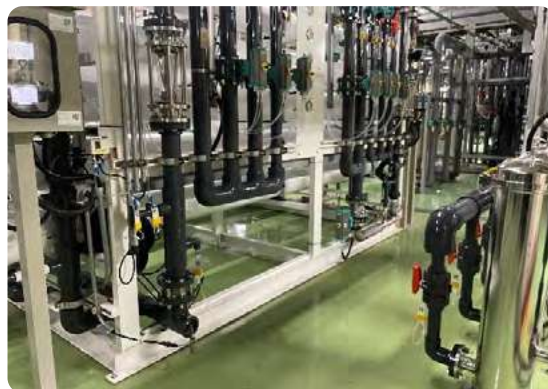
切割研磨廢水透過水資源處理，可分離過濾出乾淨的水與矽污泥塊
