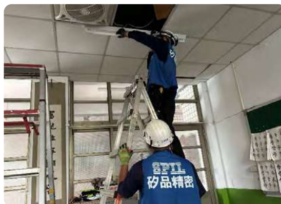
矽品精密汰換老舊燈管安裝 LED 燈具
